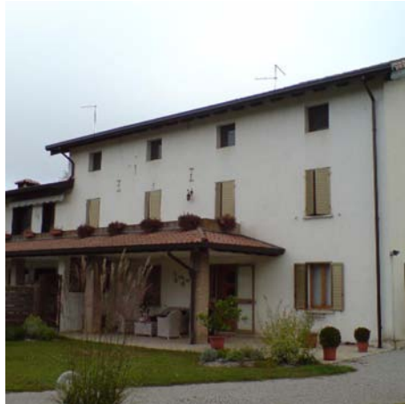
(a) Facciata W
