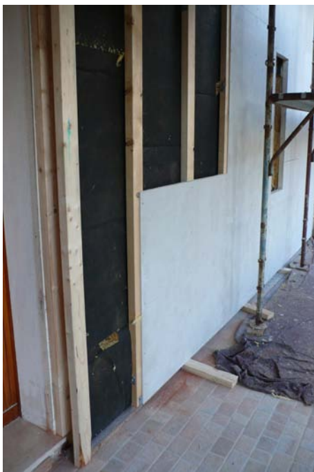
(a) Pannello Bluclad applicato in facciata ventilata
